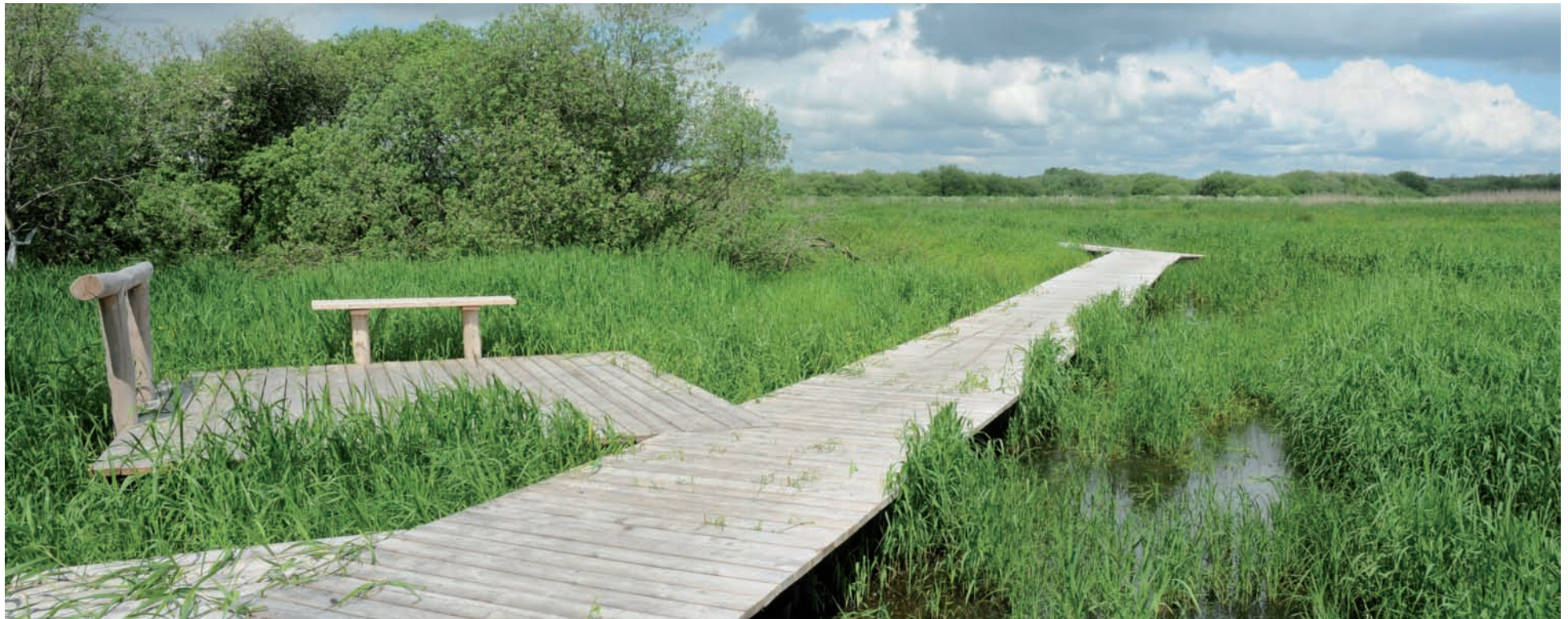
Gangbroer i Uldum Kær med pæle i robinia og bærebjælker, vanger og dæk i sibirisk lærk – udført af Woodways
