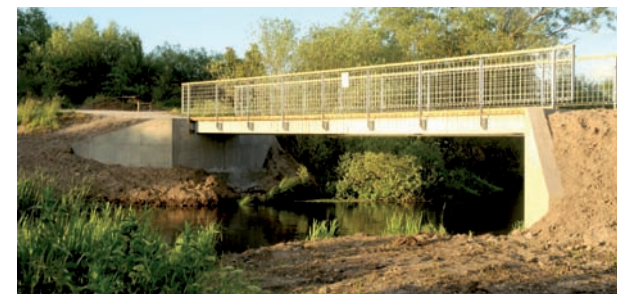
Langå Miljøgruppes stibro over Nørreåen ved Fladbro, Purhus Entreprenørforretning og BK Teknik Allingåbro
